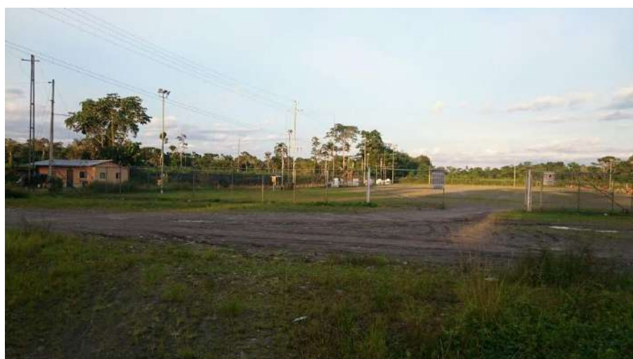
Figura 24: Servicio Eléctrico comunidad Reina del Oriente.
