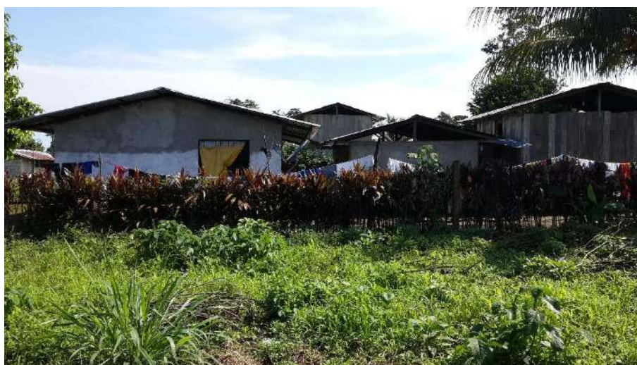
Figura 21: Estado de las viviendas en la Parroquia Enokanqui.
