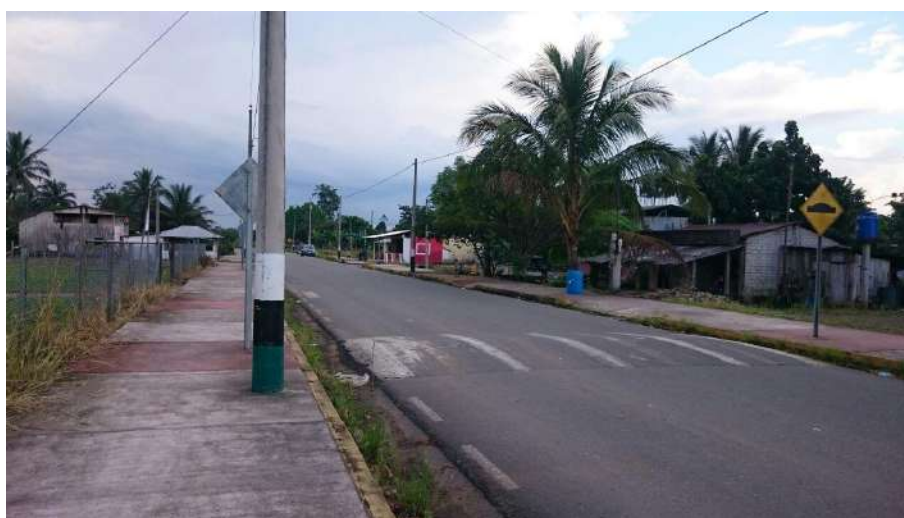
Figura 25: Vía pavimentada comunidad El Progreso.
